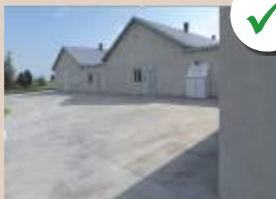
Zona perimetral hecha de concreto
