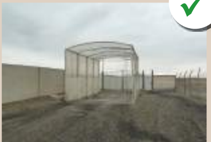
Túnel de desinfección para vehículos
