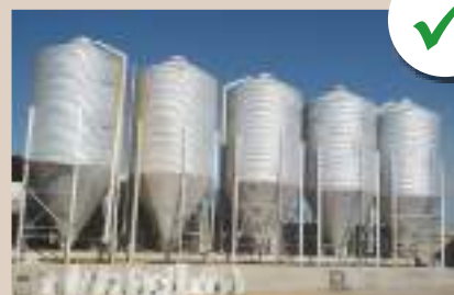
Silos en buena condición
