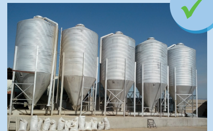
Silos en bon état
