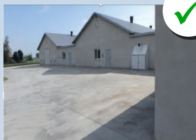
Окружающее покрытие из бетона
