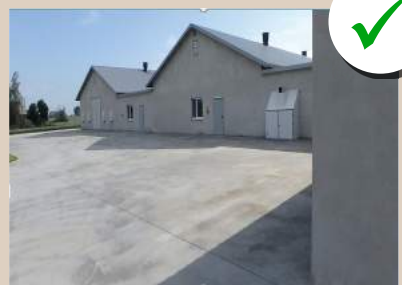
Окружающее покрытие из бетона
