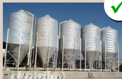
Силосы в хорошем состоянии
