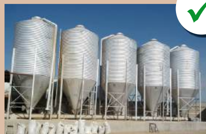
Силосы в хорошем состоянии
