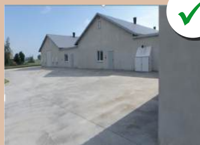
Окружающее покрытие из бетона
