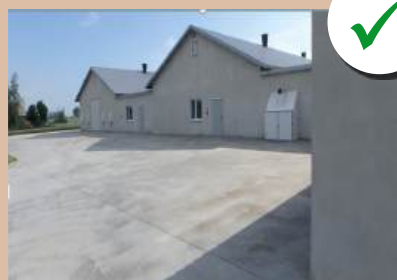
Окружающее покрытие из бетона
