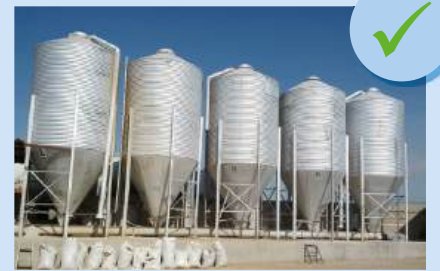
Silo trong điều kiện tốt
