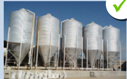
Silos en buena condición
