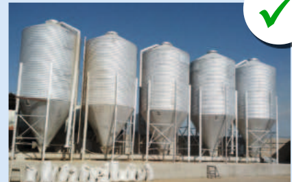
Silos en buena condición
