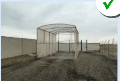
Túnel de desinfección para vehículos
