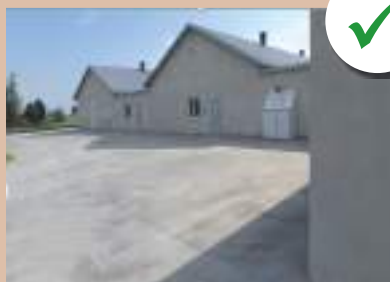
Zona perimetral hecha de concreto
