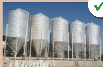
Silos en buena condición
