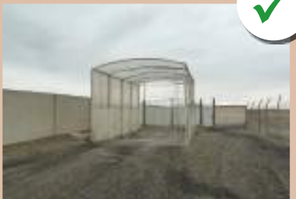
Túnel de desinfección para vehículos
