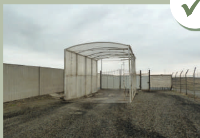
Túnel de desinfeção para veículos
