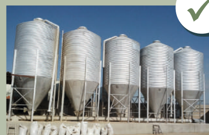
Silos em boas condições
