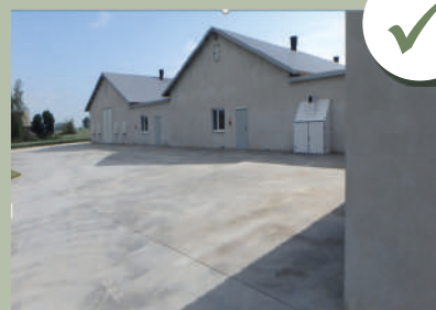
Zona adjacente cimentada
