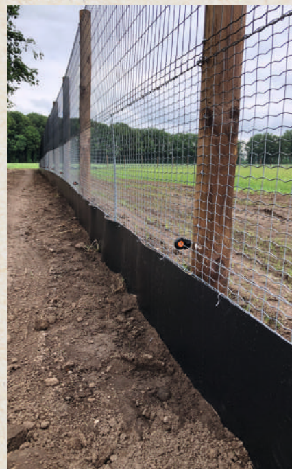
Adequado cerceamento do parque exterior
