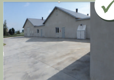
Zone bétonnée autour du site
