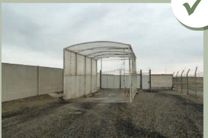
Tunnel de désinfection pour les véhicules
