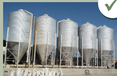
Silos en bon état
