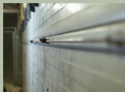
Installation d'une brume dans le bâtiment d'élevage
