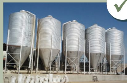
Silos en bon état
