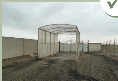
Tunnel de désinfection pour les véhicules
