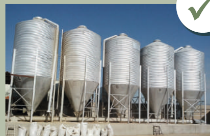
Silos en buenas condiciones
