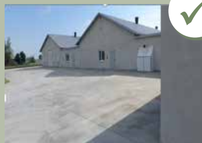
Zone bétonnée autour du site
