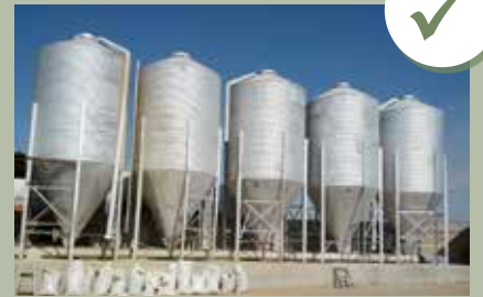
Silos en bon état
