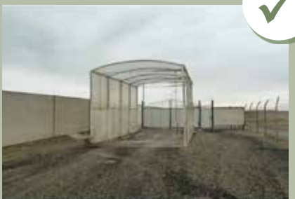
Tunnel de désinfection pour les véhicules
