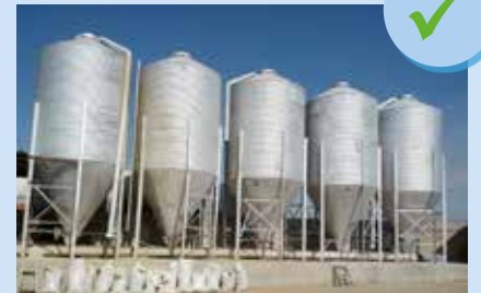
Silos en bon état
