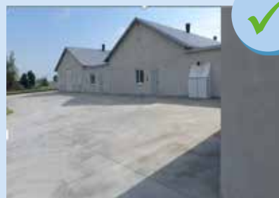
Zone environnante bétonnée
