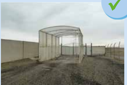
Túnel de desinfección para vehículos
