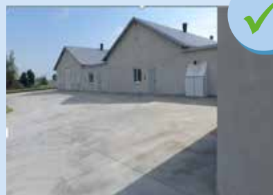
Zona de cemento en los alrededores
