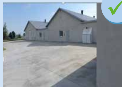
Zona de cemento en los alrededores
