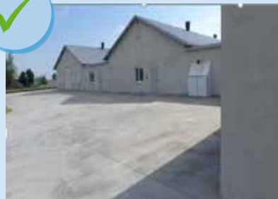
المنطقة الخرسانية المحيطة
