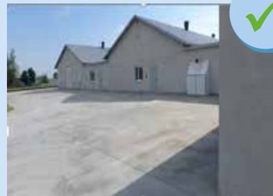
Çevreleyen beton bölge
