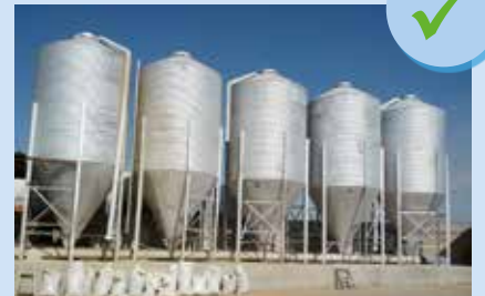
Silos em boas condições
