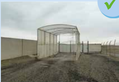
Túnel de desinfecção para veículos
