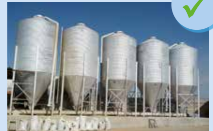
Silos in buone condizioni
