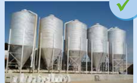
Silos en buenas condiciones
