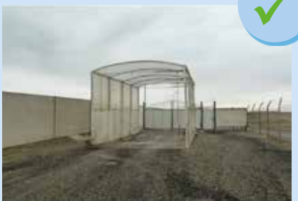
Túnel de desinfección para vehículos
