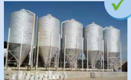
Silos in gutem Zustand
