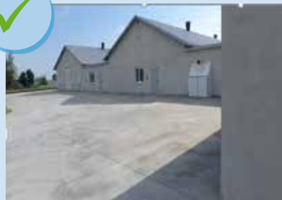
المنطقة الخرسانية المحيطة
