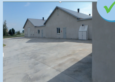
Çevreleyen beton bölge
