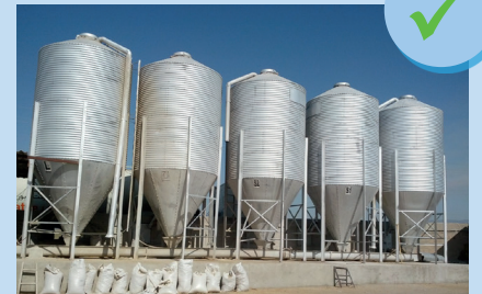
Silos in buone condizioni
