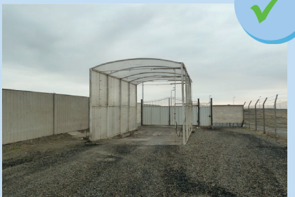
Tunnel de désinfection pour les véhicules
