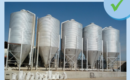
Silos en bon état
