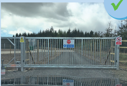
Barrière fermée avec signalétique de biosécurité
