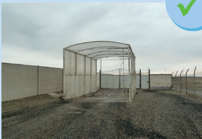
Túnel de desinfección para vehículos
