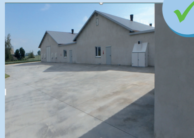
Çevreleyen beton bölge
