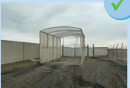
Túnel de desinfecção para veículos
