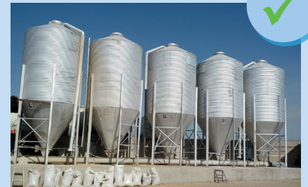
Silos em boas condições
