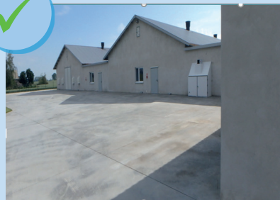
المنطقة الخرسانية المحيطة
