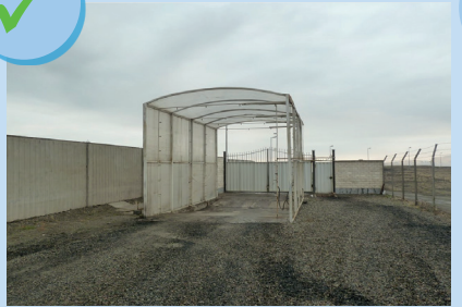
نفق لتطهير المركبات
