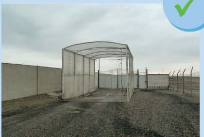
Túnel de desinfección para vehículos
