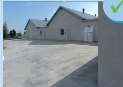
Çevreleyen beton bölge
