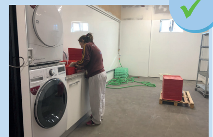
Machines à laver et séchoirs installés dans l'exploitation
