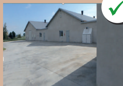
Zona perimetral hecha de concreto
