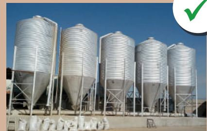
Silos en buena condición
