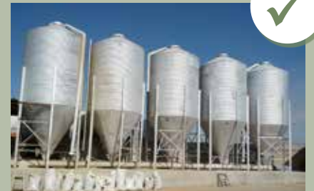
Silos en buenas condiciones
