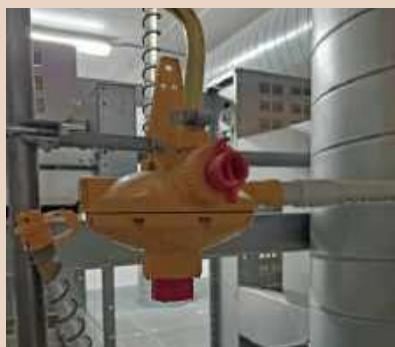
System przepłukiwania instalacji wodnej (sterownik przepływu wody)
