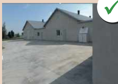
Betonową strefę oddzielającą
