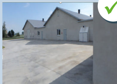
Zona perimetral hecha de concreto
