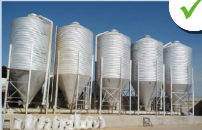
Silos en buena condición
