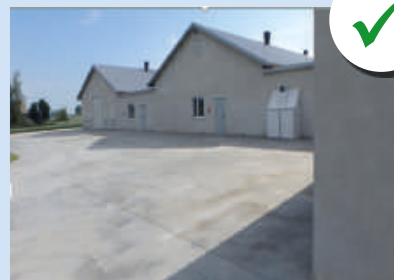
Zona perimetral hecha de concreto
