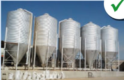
Silos en buena condición
