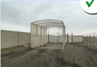
Túnel de desinfección para vehículos
