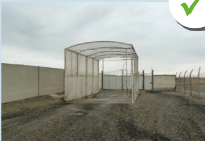
Túnel de desinfección para vehículos
