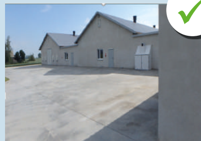
Zona perimetral hecha de concreto
