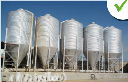
Silos en buena condición
