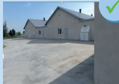
Çevreleyen beton bölge
