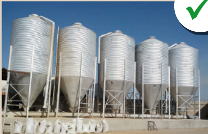
Silos en buena condición
