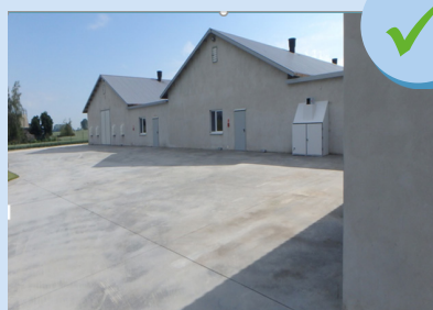
Betonierte Flächen um den Stall
