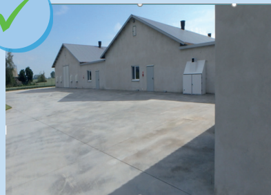
المنطقة الخرسانية المحيطة
